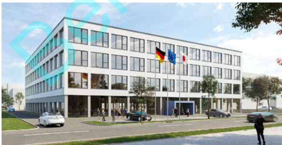
Yaskawa baut in Hattersheim bei Frankfurt/Main eine neue Unternehmenszentrale für Europa – die Einweihung ist für Ende 2022 geplant. (Bild: Yaskawa)
